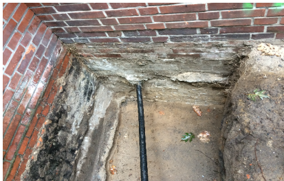
Freilegung Fundamente Übergang Sporthalle/ Bestand
